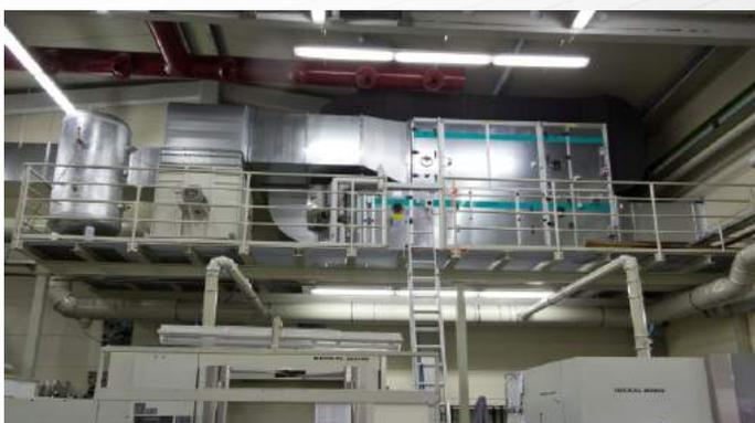
Durch ein zusätzliches Kühlregister in der RLT-Anlage kann die Zuluft klimatisiert werden.
