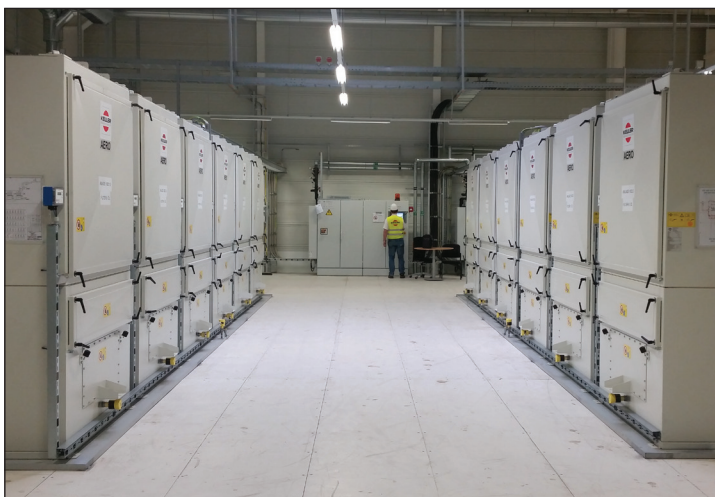
Zentrale Absauganlage aus zwölf AERO®-Modulen der Baugröße 3 Nennluftmenge 140 000 m³/h
