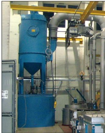
Nassabscheider VDN-T mit Wasservorratsbehälter
